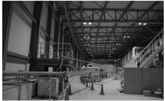
蓄積リング棟実験ホールと放射光が通るパイプ
