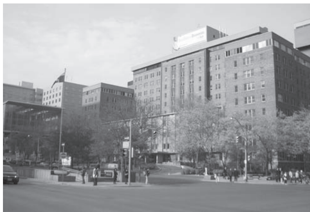
写真1 ユニバーシティ通り側から見たトロント小児病院（旧館、右側）。写真左端の建物は、隣接するトロント総合病院（Toronto General Hospital）。
