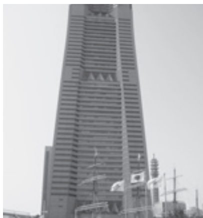
会場となった横浜ランドマークタワー
